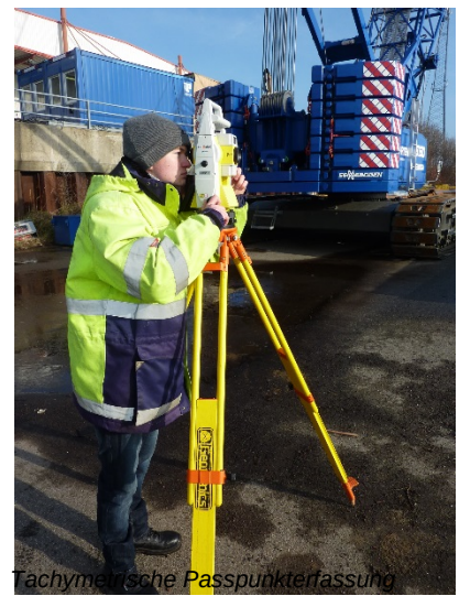
Tachymetrische Passpunkterfassung
